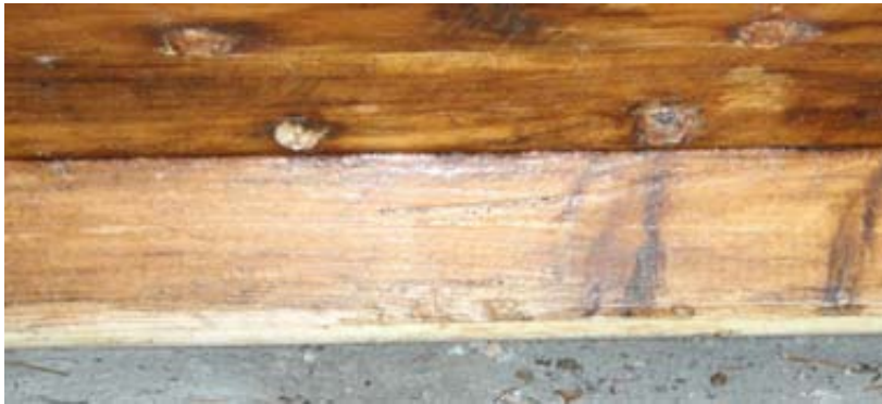
Draget på nyefæringen, den tynne lyse fôringa nedst på kjølen.
